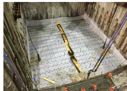
Færdig udlagt membran inden støbning
