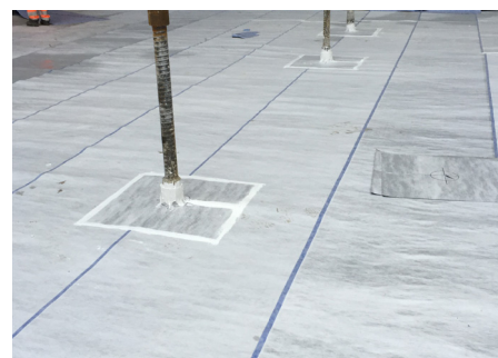
Tætning af detalje med HyDra Swelling Paste
